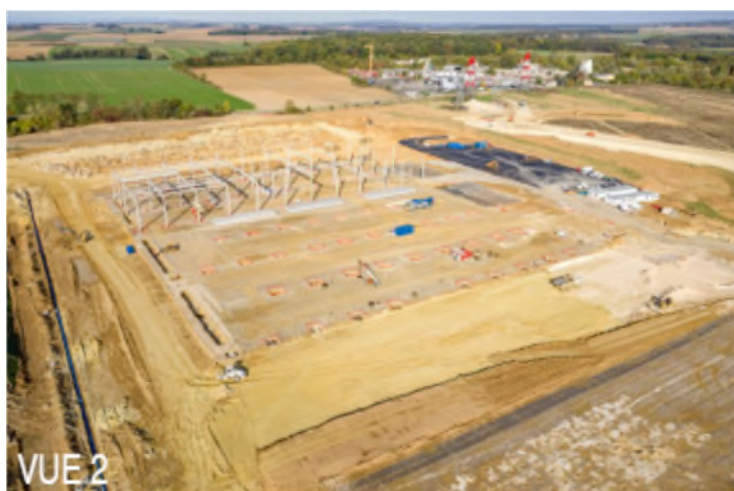
Figure 6 : vue du terrain Sud-est vers le Nord-ouest - 2018
